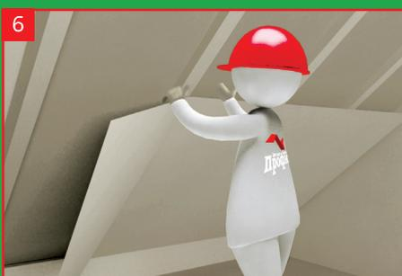
6. На внутренней поверхности стропил степлером закрепляются полотнища пароизоляционной пленки «ЮТАФОЛ Н СИЛВЕР» или «Изоспан В», полотнища укладываются внахлест и герметично соединяют клеевой лентой. После этого можно установить внутреннюю облицовку.
